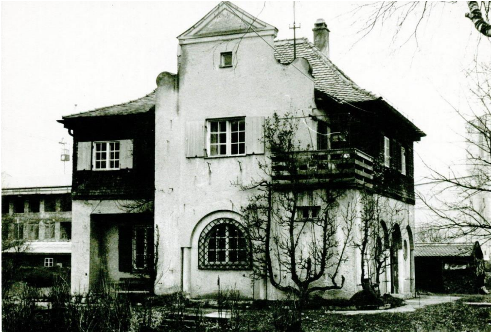
Das Wasserwerk vor dem Abriss im Jahr 1965. Im Hintergrund ist die Mittelschule schon im Bau.
